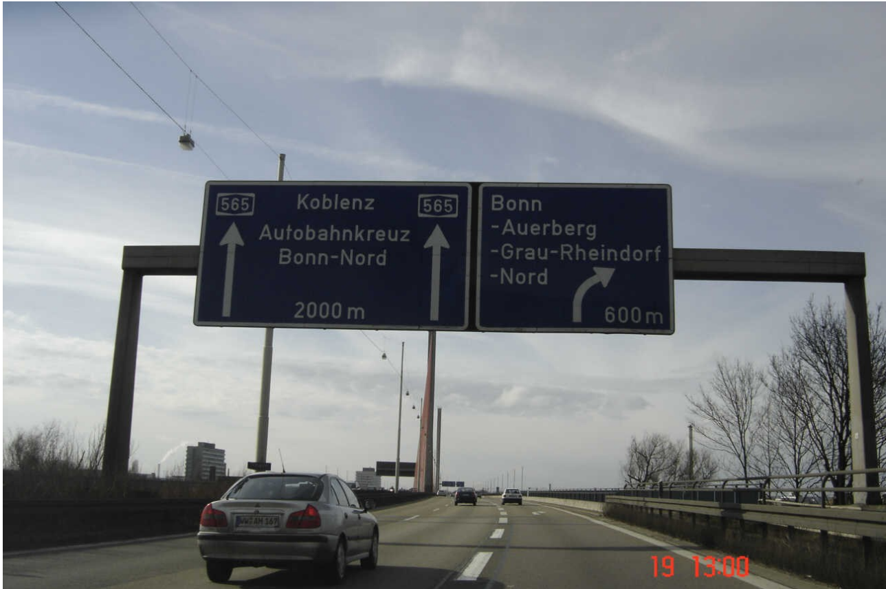
AS Bonn Auerberg. Hier führt die Abbiegespur als dritte Spur über die Nordbrücke (Rheinquerung).
