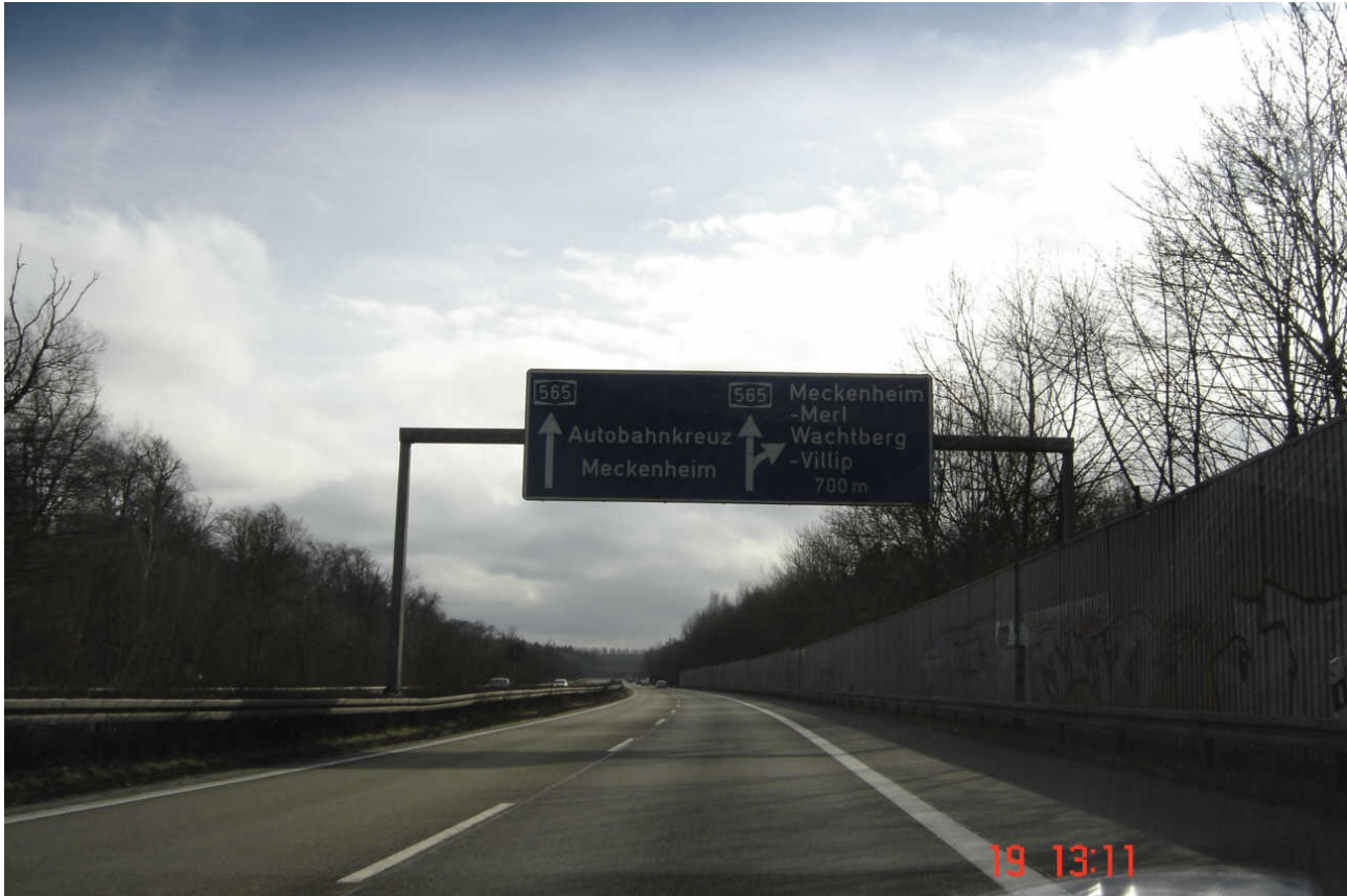
AS Meckenheim/ Wachtberg. In Meckenheim befindet sich eine Außenstelle des BKA.
